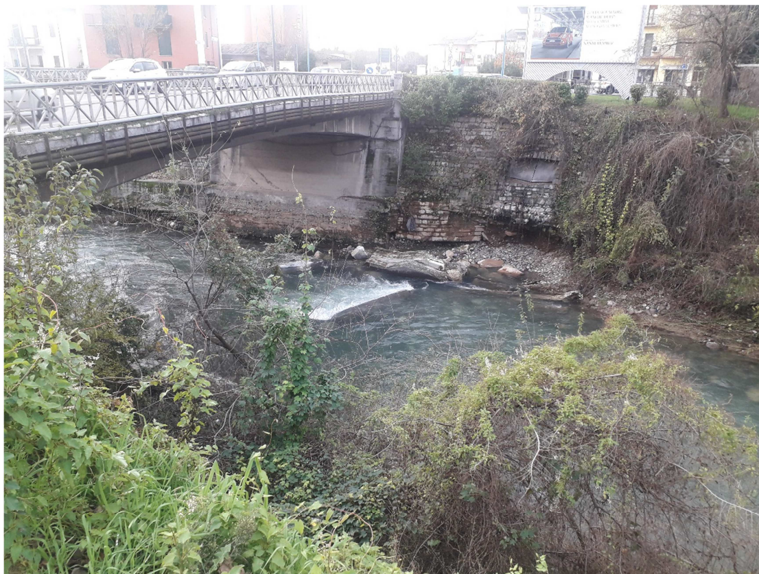
Immagine 1 – la zona di rifacimento del fondo e delle due massicciate di protezione delle spalle del ponte
