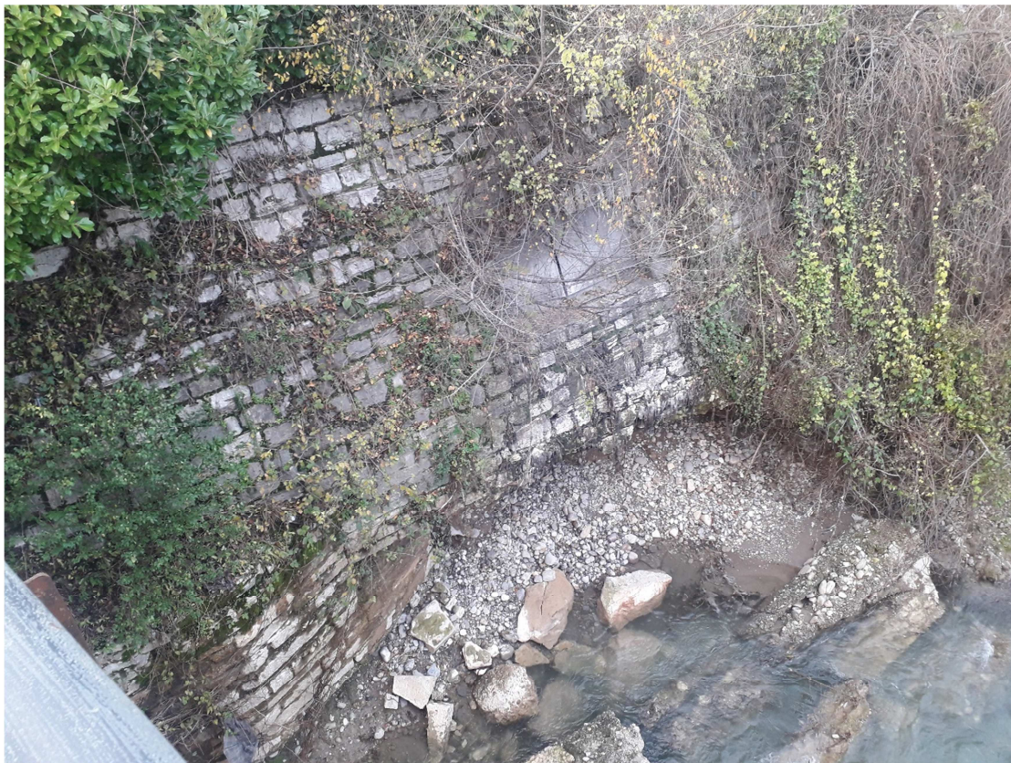
Immagine 3 - cedimenti di materiale in alveo, da sistemarsi mediante nuove protezioni alle spalle del ponte
