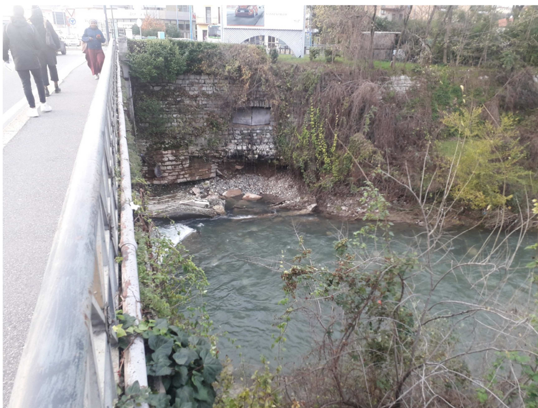
Immagine 2 – la zona di rifacimento del fondo e delle due massicciate di protezione delle spalle del ponte. Veduta sulla spalla destra, in forte erosione
