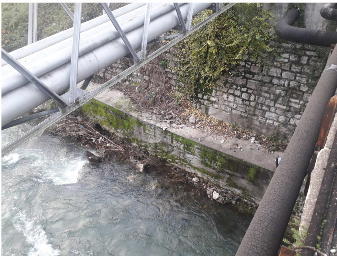
Immagine 4 – erosione da parte del fiume a carico della spalla del ponte.
