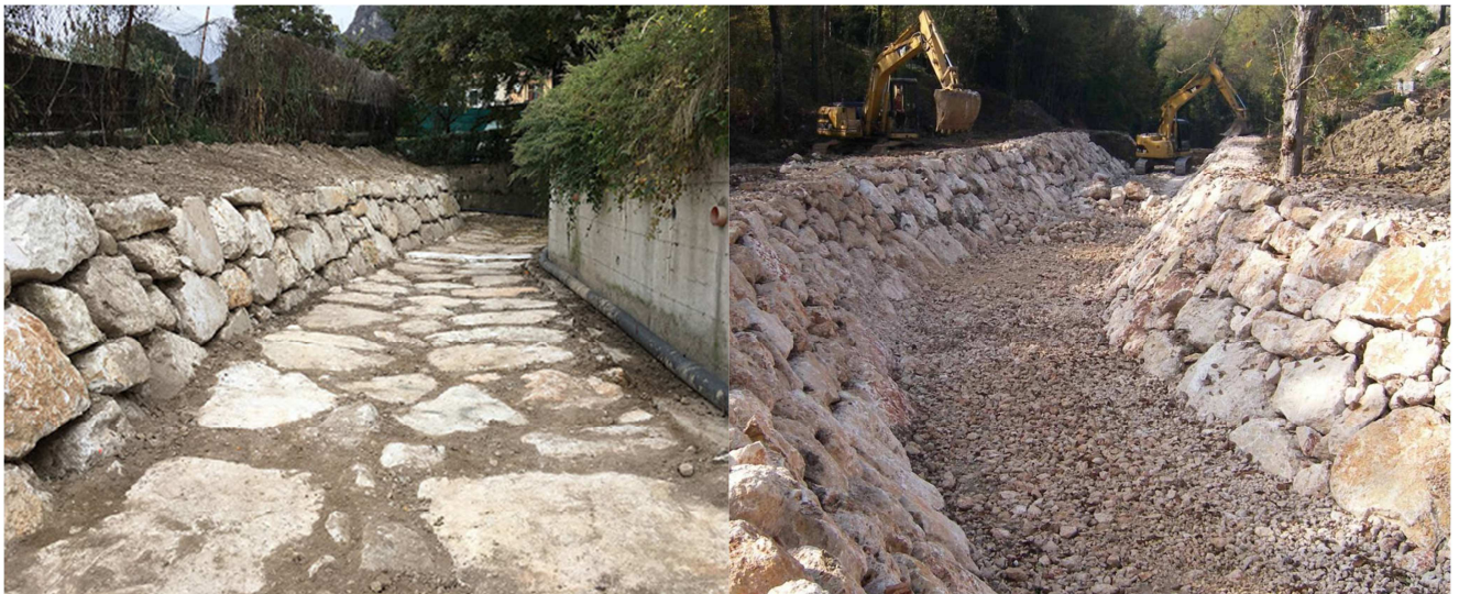
Esempi di scogliere di protezione spondale in massi posati a secco
